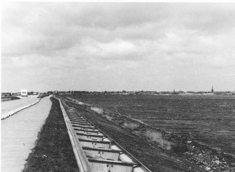
Houtribdijk bij naviduct gezien op Enkhuizen
